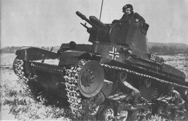
Ein Skoda 35 (t) der 5./Pz.Rgt. 11. Das Foto zeigt gut sein charakteristisches Merkmal: Die kräftige Rohrbremse oberhalb der 3,7 cm (A-3) Kanone.
