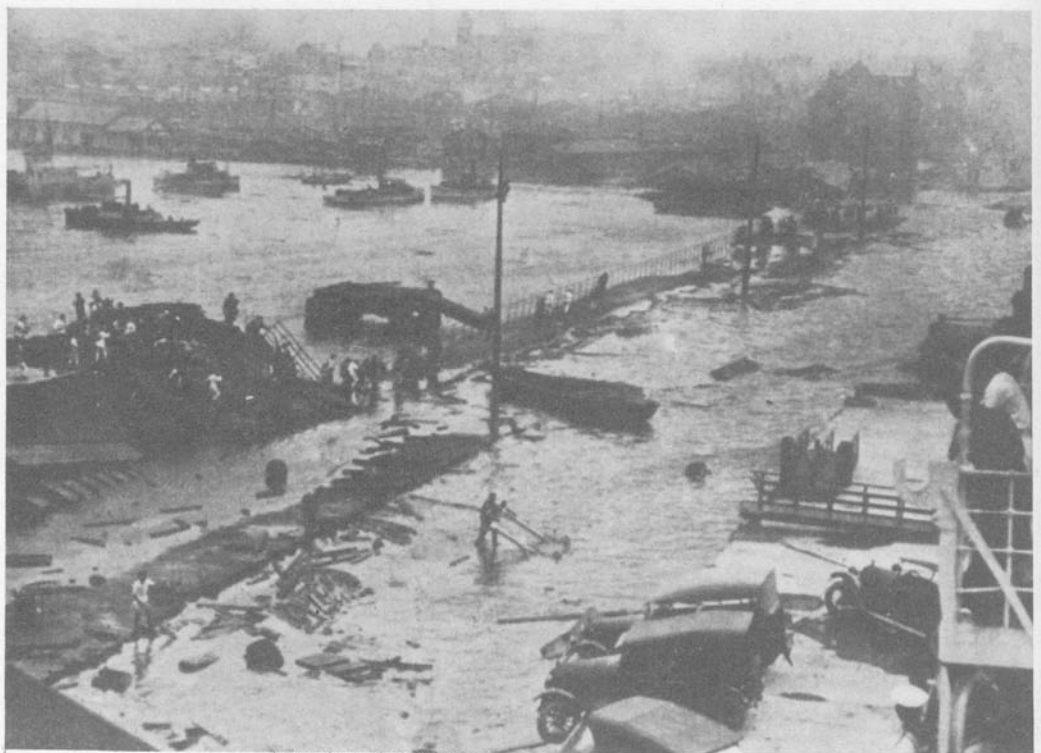
Le raz de marée à Yokohama.
