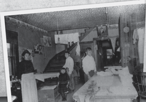
Une laverie, au rez-de-chaussée d'une habitation
